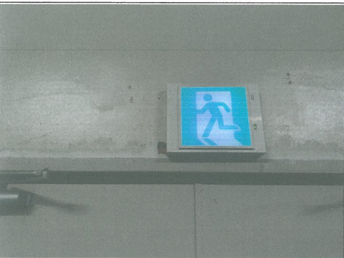
피난 유도등 중형 축적 불량 10개소 배터리 교체
