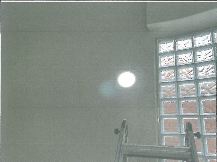
중앙 계단 옥상 층 벽 등 1개소 커넥터 교체 및 제 결선
