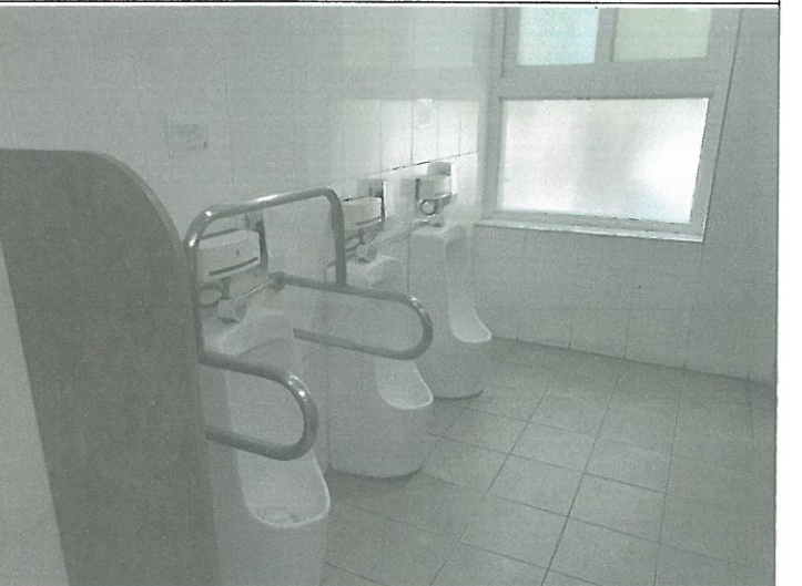
1층 남자 화장실 소변기 통수
