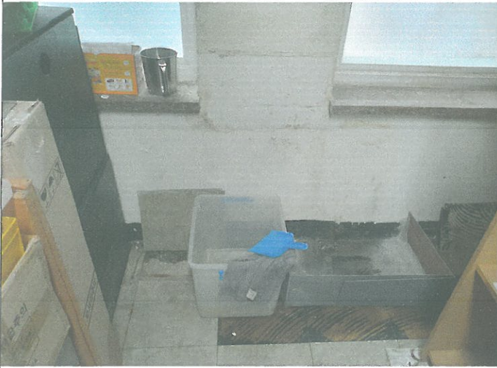
2층 창고 외벽누수개소 내부 집수정 임시 시공
