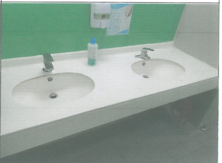
3층 여자 화장실 세면대 통수
