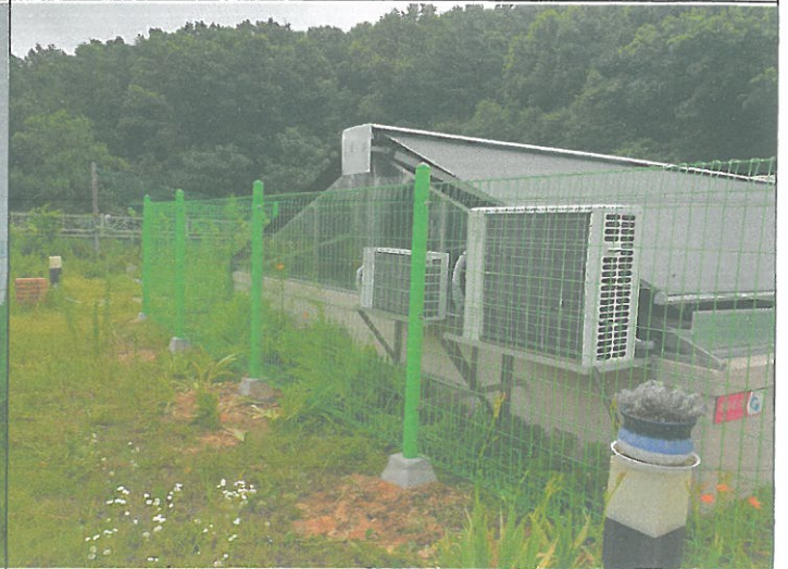
옥상 안전 구조물 설치
