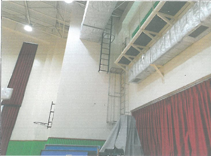
대체육관 수직사다리 안전 구조물 설치
