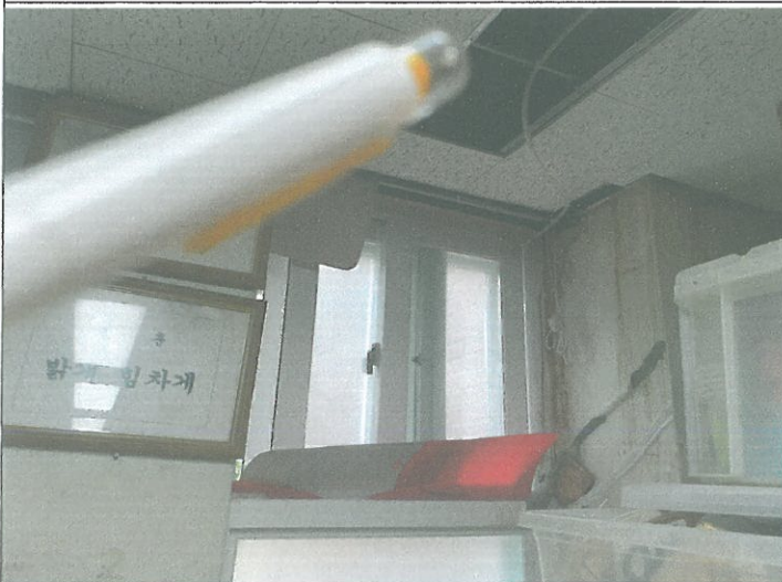
2층 창고 벽면 유입빛물 바닥 물유입 창틀 유도로 설치
