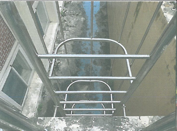
수영장 선글실 수직형 사다리 안전 구조물 설치
