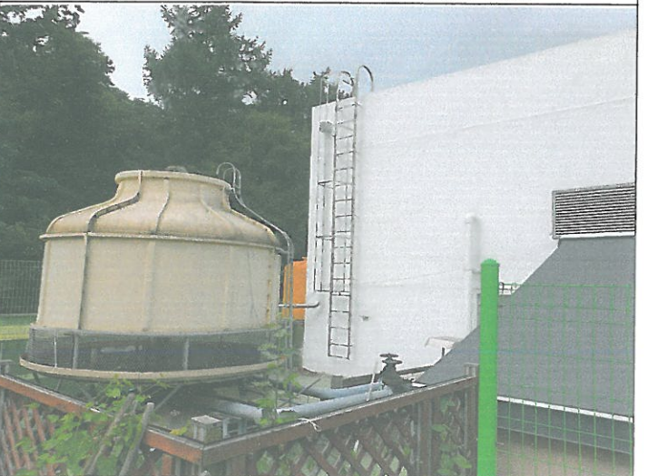
공조실 옥상 수직형 사다리 안전 구조물 설치
