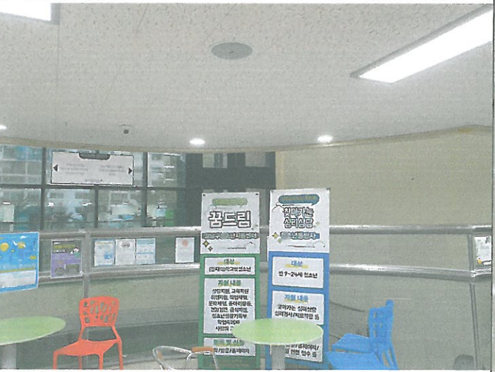
2층 로비 천장 다운라이트 2개소 교체
