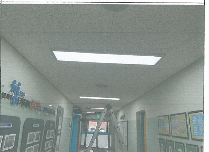
1층 주차장 출입구 천장 등 1개소 교체
