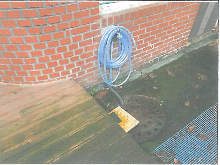
수영장 외부 입구 청소용 호수 설치
