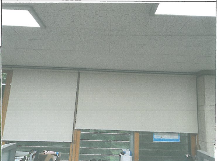
3층 청소년 사업팀 창문 커튼 바 4기 규격 교정 조립
