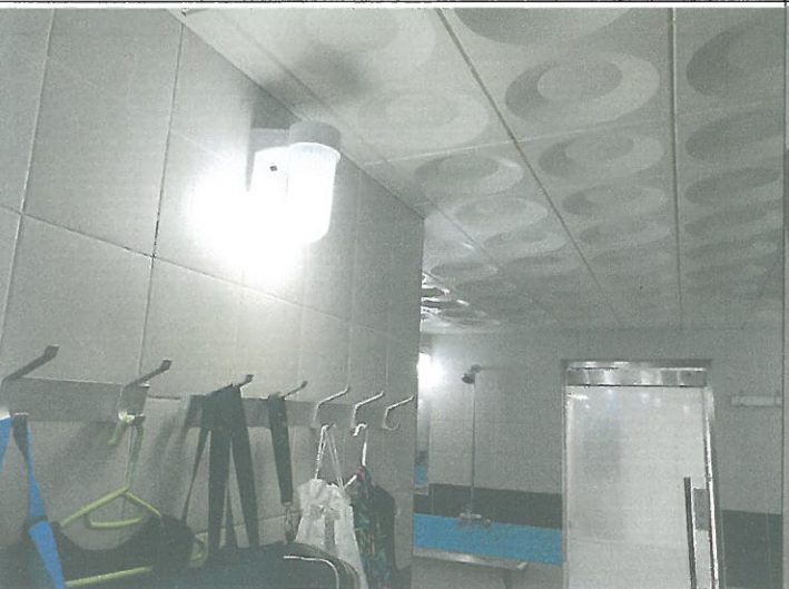
수영장 남자 샤워장 내 벽등 1개소 전구 교체
