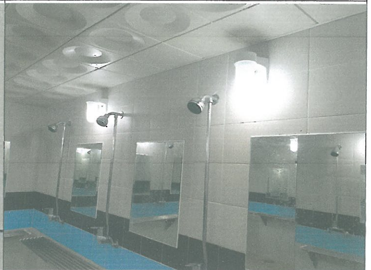
수영장 남자 샤워장 샤워기 헤드 1개소 교체
