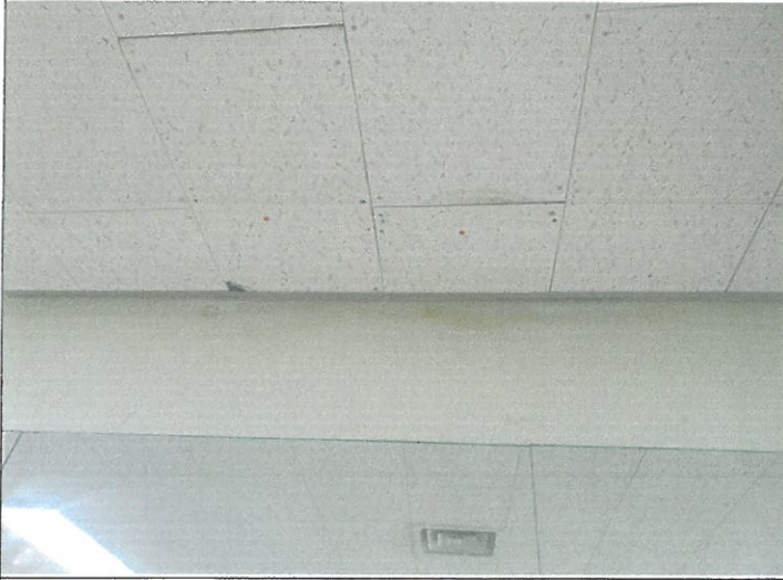
3층 모듬실 천장 텍스 1곳 탈락 보수
