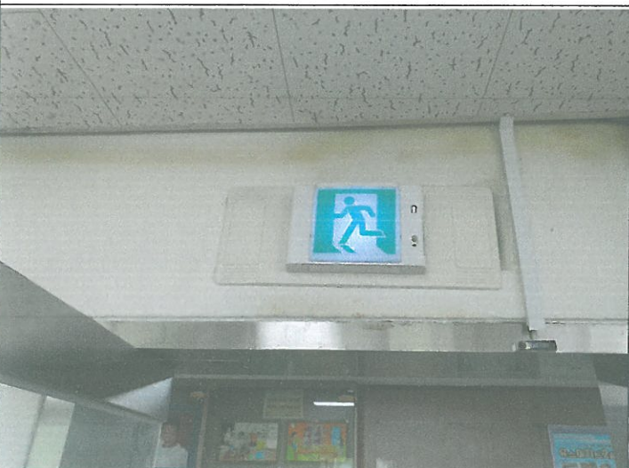
옥상.3층.2층.1층 복도, 피난유도등 배터리 교체
