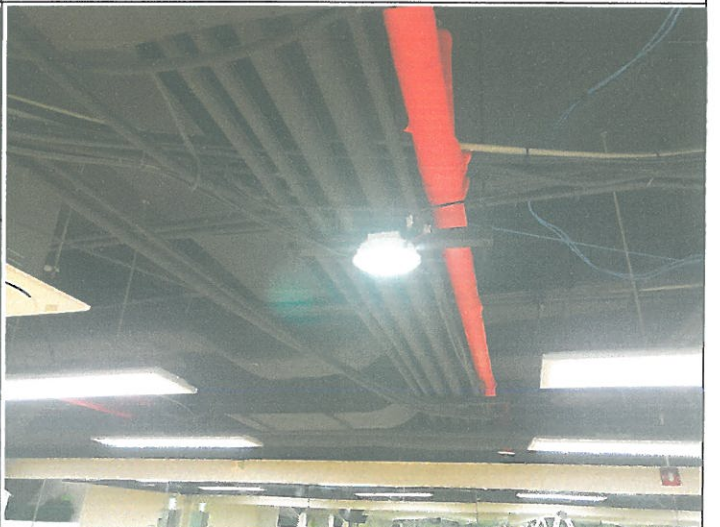
지하1층 소체육관 천장 다운라이트1개소 교체
