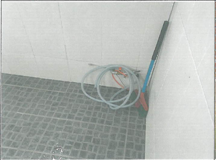
대체육관 남자 샤워실 청소용 호수 설치
