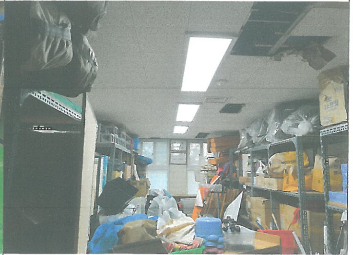
2층 창고 천정누수개소 누수물 유도물통 제작 설치
