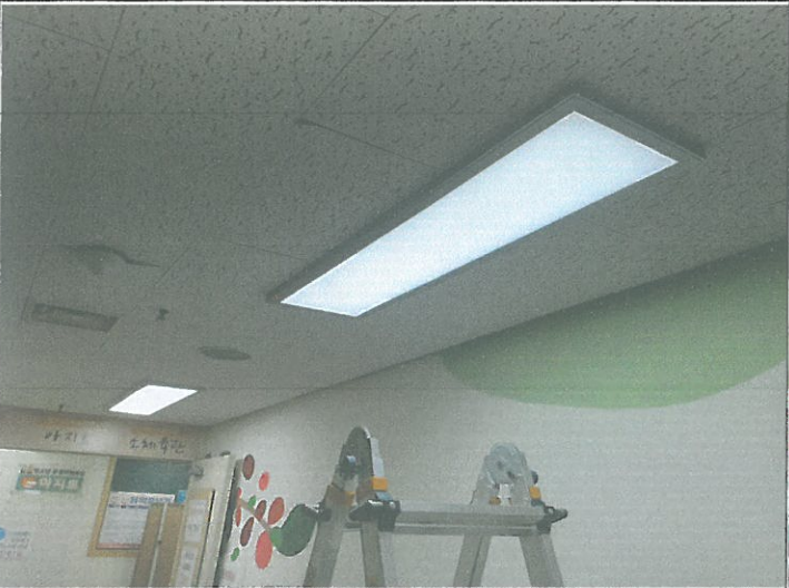
지하 1층 복도 천장 매립 등 1개소 교체
