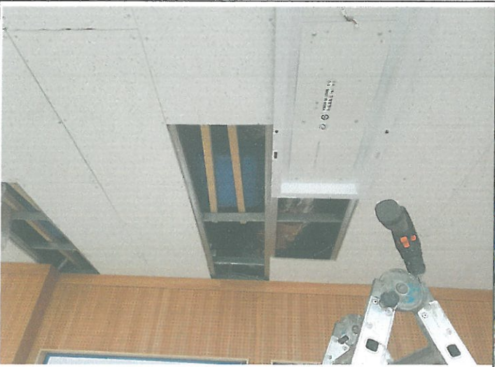
3층 스페이스 실 텍스 교체 및 물 받이 통 설치
