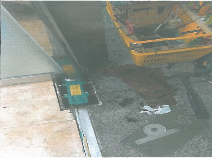
수영장 로비 외부 출입 강화문 하부힌지 교체
