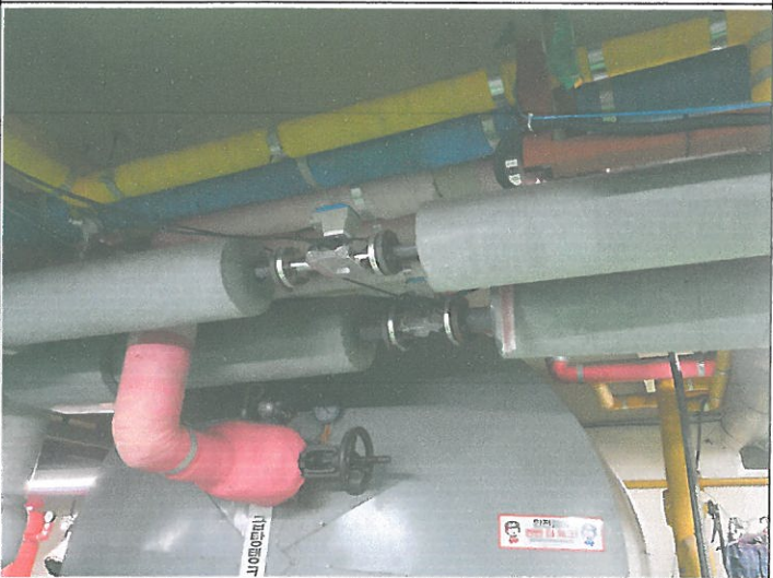
수영장 지역난방 차압밸브 후렌치 누수개소 볼트 조임조치
