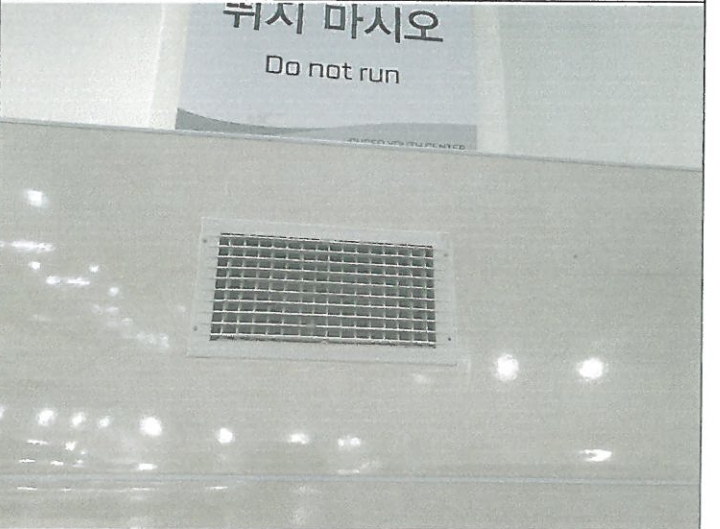
수영장 내 댐버 탈거 되어 제부착
