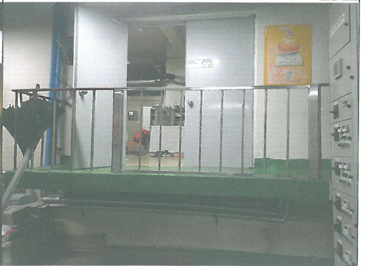
수배전실 앞 난간 안전바 설치
